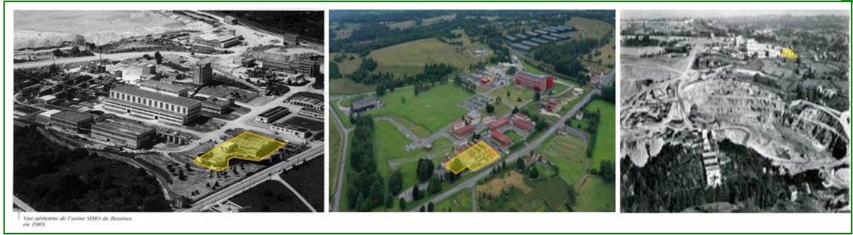
Figure 12 : Vue aérienne de l'établissement (SIMO en 1985 à gauche, SIB en 2023 au milieu, et SIMO en 1967 à droite) – Repère en jaune des bâtiments J-H réhabilités
