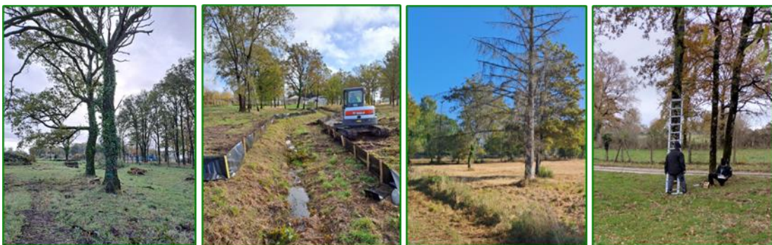
Figure 26 : Balisage des arbres et défavorabilisation des zones impactées réalisés
